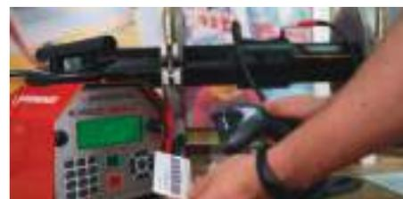
После фиксации трубы производится обезжиривание внешней поверхности трубы и внутренней поверхности фитинга с использованием специальных салфеток, пропитанных этиловым спиртом. При этом не допускается использование окрашенных тканей или пропитка ацетоном или другими растворителями.
